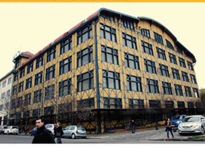
7. Edificio Hucke Año de fundación: 1892 Ubicación: General Cruz 222
